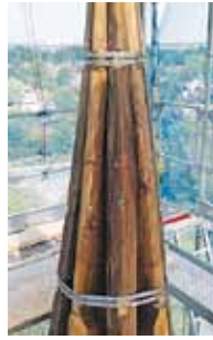
FOTO: DAVID CAMRELL Efter många års slitage är det dags att sätta nytt tak på tornet på Brännkyrka kyrka. I samband
